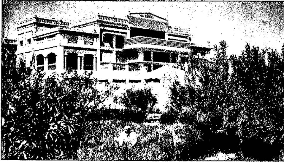
١٥- القصر الجديد للملك الذي بني بالإسمنت المسلح (يكسر بساطة المربع المتميز بفن العمارة الطينية).
