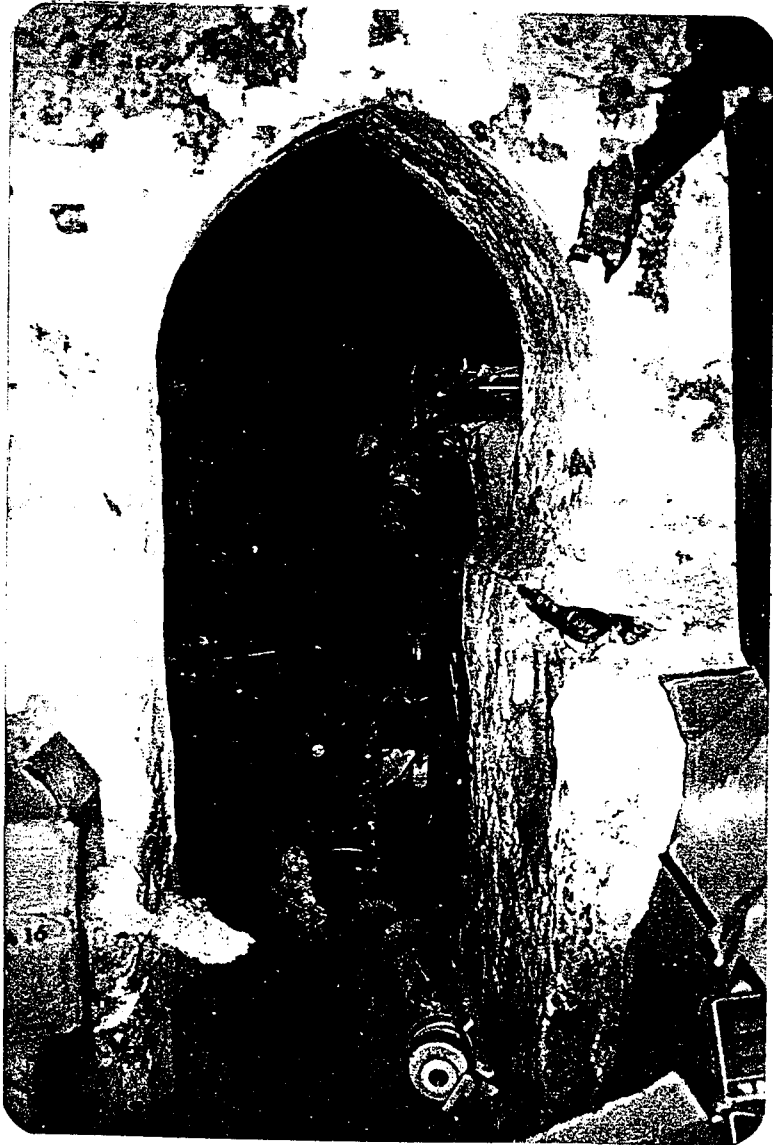
لوحة رقم (١٥٢): حنيه ركنيه لتحويل المنطقه المربعه الى دائره في الغرفه الساخنه .
