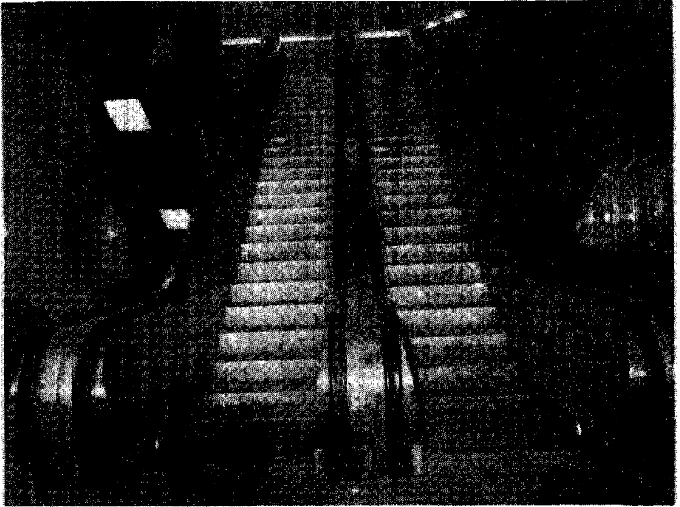
منظر للسلام الكهربائية. مبنى التوسعة السعودية الثانية .
