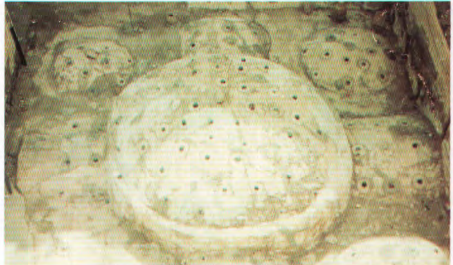
(١٠٠) (الحمامات) صورة للمسقط الأفقي لسطح حمام العنبرية المعروف بحمام الترجمان، وتظهر القبة الرئيسية التي تتوسط الحمام وتحاط بالقباب الجانبية التي تمثل الخلوات أو المراوش.
