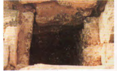
(١٢٣) (المناهل) صورة تمثل فتحة أحد المناهل وقد طويت جوانبها بالحجارة لضمان عدم انهيار المنهل ، ويستخرج منه الماء باستخدام الدلو .
