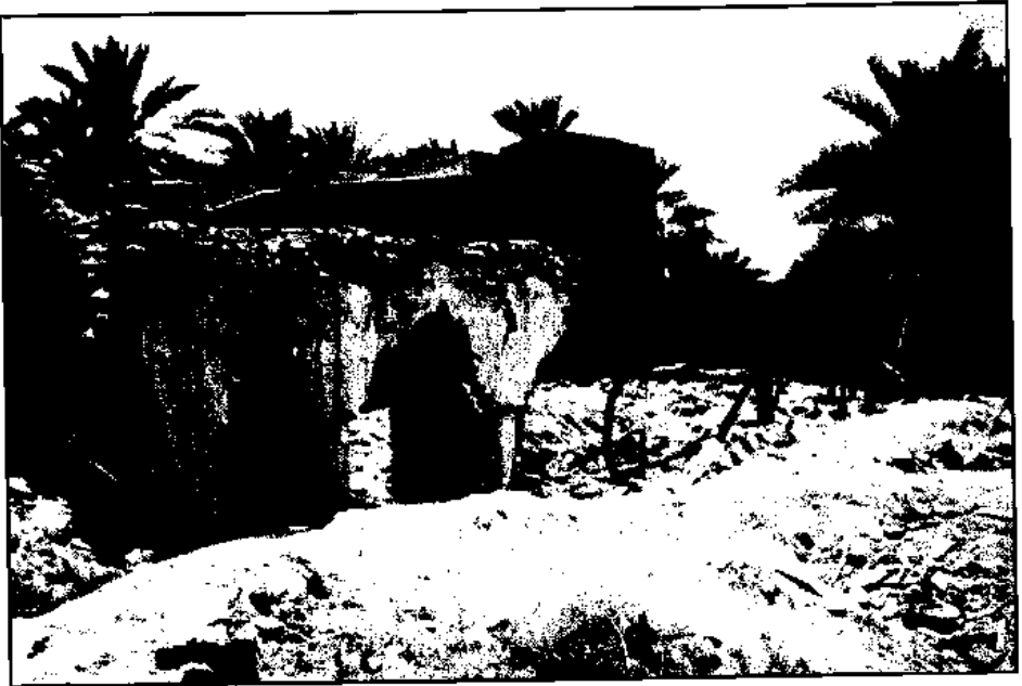
مسجد فيحان القديم المبني سنة ١٣٠٨هـ ويلاحظ سقوطه
