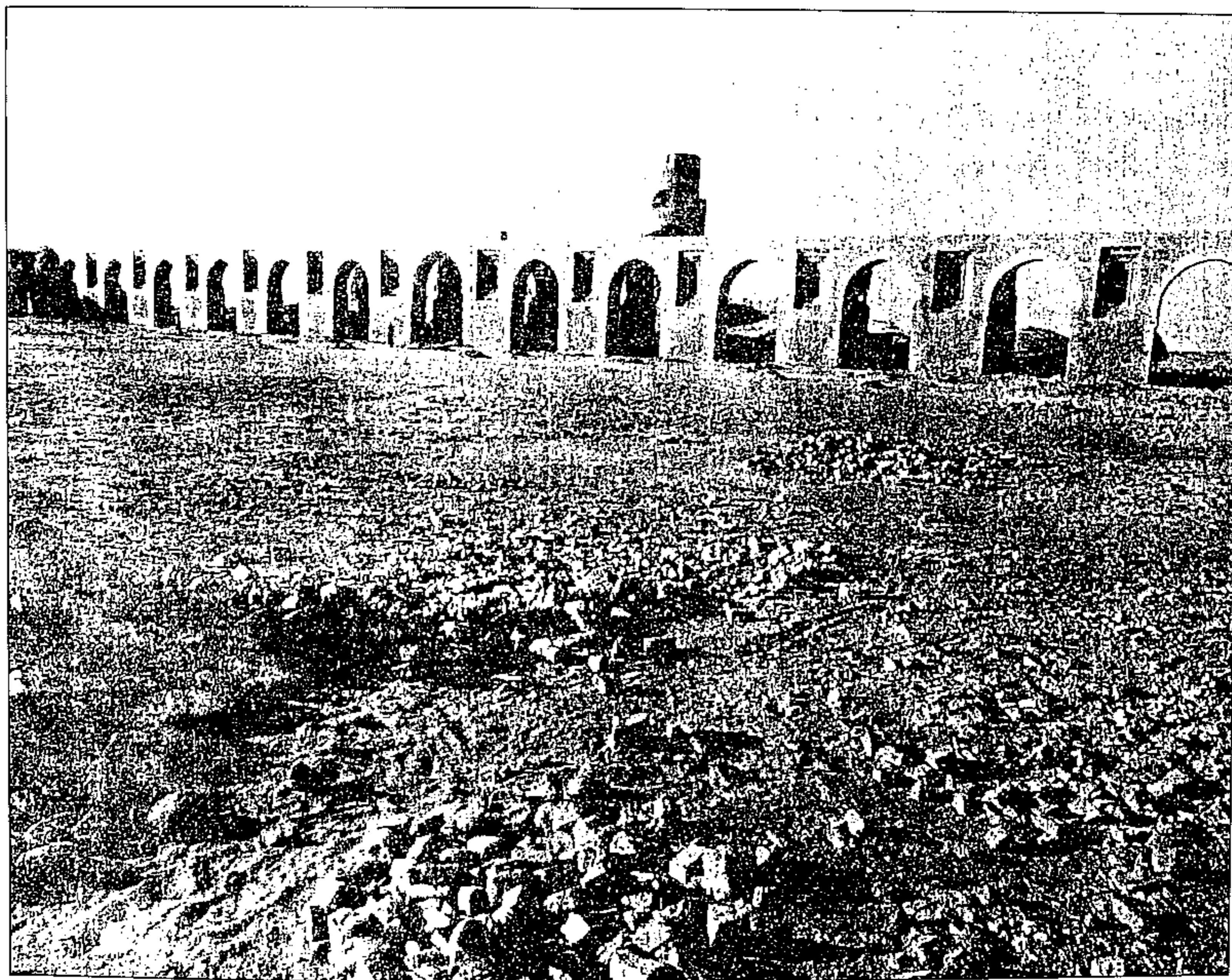
عقود مقدم المسجد بعد أعمال الترميم والصيانة من الداخل
