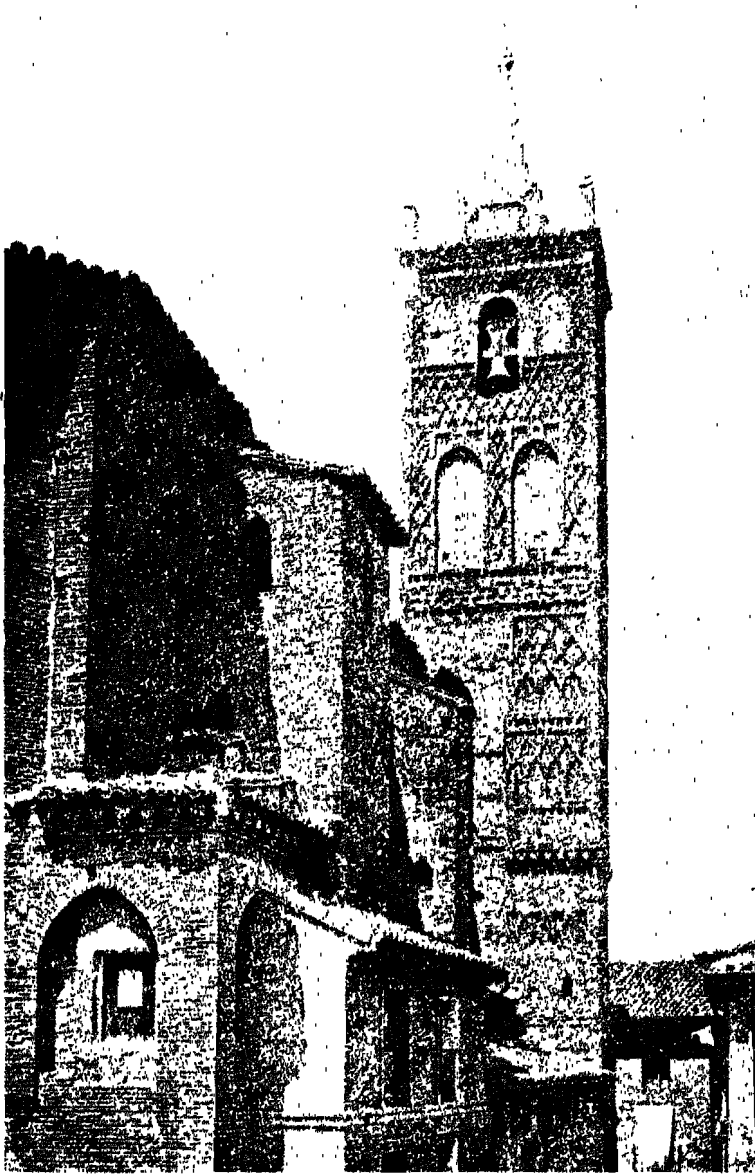
الشكل : ٤ البناء المذبحي الأجرى ( برج سان جيل : ساراكوسا Saragossa. Torre de San Gil )
